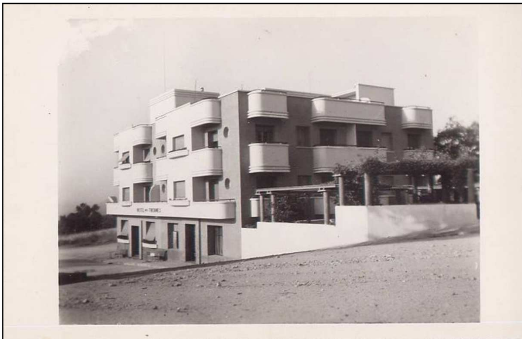
L'hôtel des Thermes construit peu après 1935. Sans doute la seule prestation hôtelière offerte aux curistes à Oulmès les Thermes.
