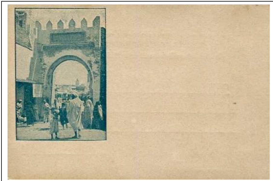
CPP : Porte à Tanger éditée par l'Imprimerie Nouvelle Photographique.
