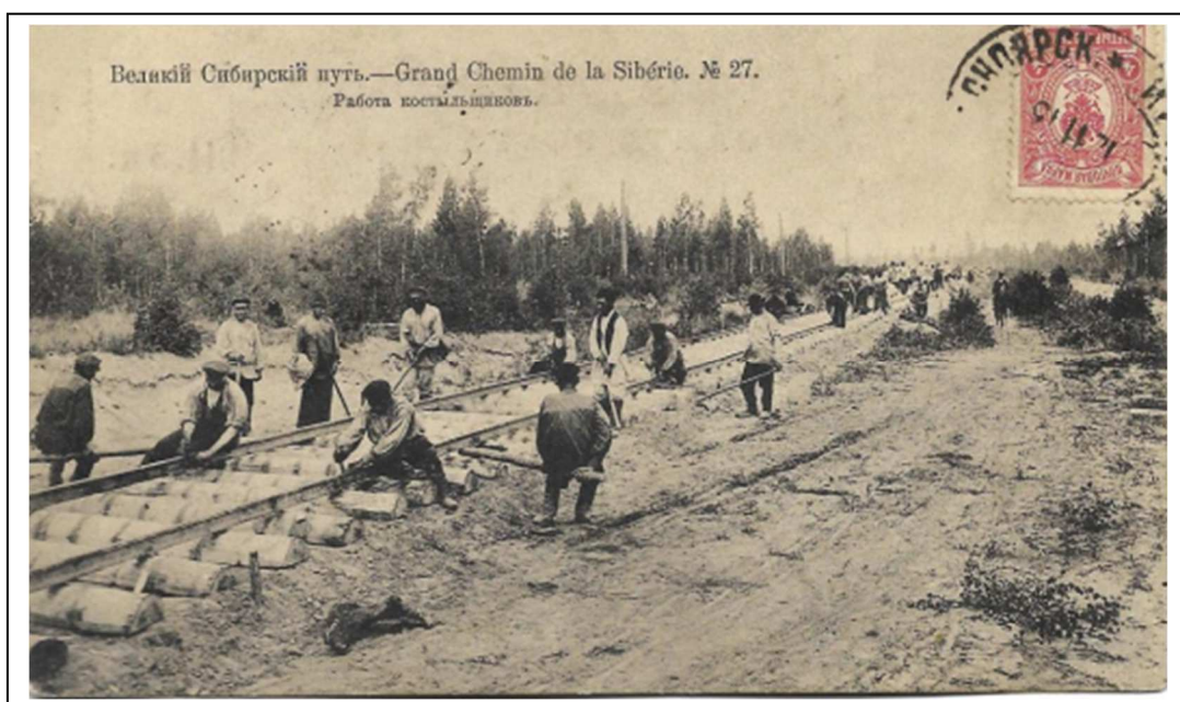
Pose de rails de chemin de fer du transsibérien
