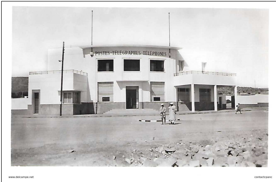
L'ancienne poste principale d'Agadir, avant le séisme
