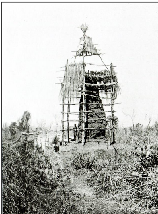
Fig.10 – Utilisation d'une grande termitière pour la construction s'un signal de triangulation.
